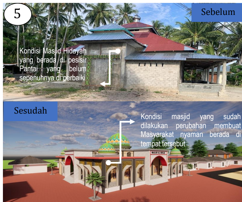
Gambar 6. Sebelum Sesudah Kondisi Masjid Hidayah Sumber : Peneliti, 2025
