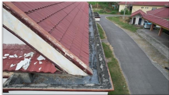
Gambar 2. Kondisi Eksisting Talang Beton (Sumber: Citra Drone oleh penulis)
