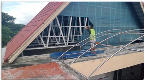
Gambar 3. Kondisi Eksisting Atap Dak Beton (Sumber: Citra Drone oleh penulis)
