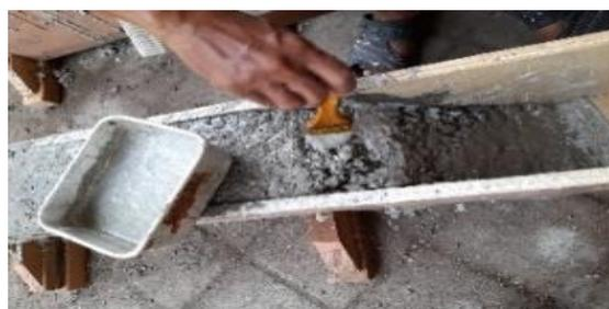
Gambar 3. Pencampuran Lem beton dan Pemberian Lem Beton pada Permukaan yang akan disambung
