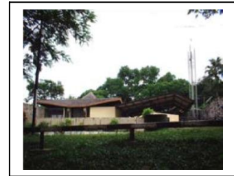
Gambar 6. Menara masjid An Nur, Jatiluhur (1971-1972). Struktur rangka pipa membentuk menara dengan karakter ringan. Menara tunggal tersebut diletakkan terpisah dari bangunan dan berperan sebagai ‘eye catcher’.
