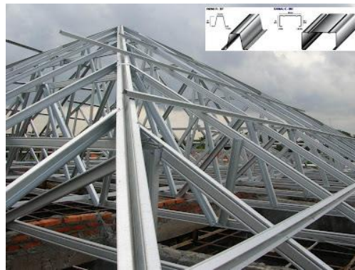
Gambar 1. Rangka Atap Baja Ringan Sumber : Dokumentasi Pribadi
